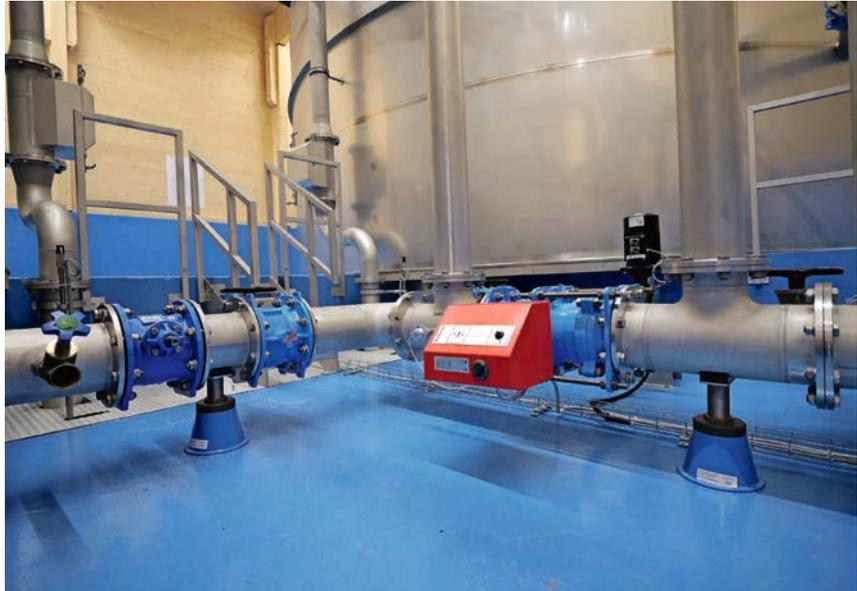
Armaturen zur Steuerung mit dem Rundbehälter Gantenstein im Hintergrund.
