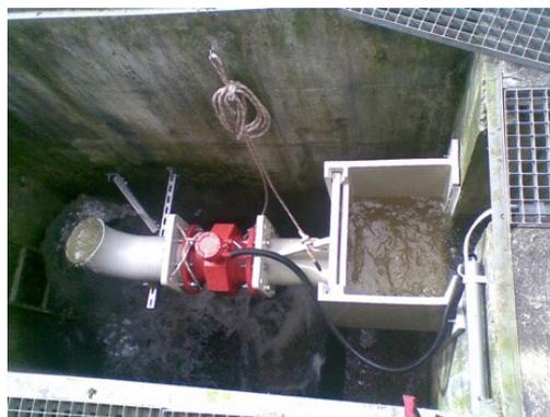
Exemple de photo d'une unité montée avec le cordon de sécurité encore en place.
