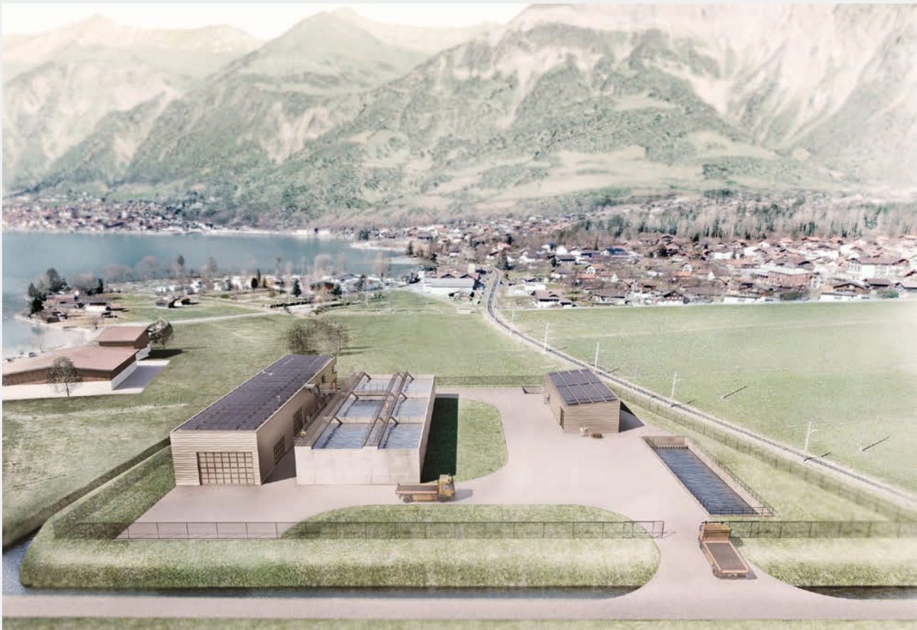
Fig. 2 Die neue ARA Brienz – High-Tech-Kläranlage, die neue Standards definiert.
