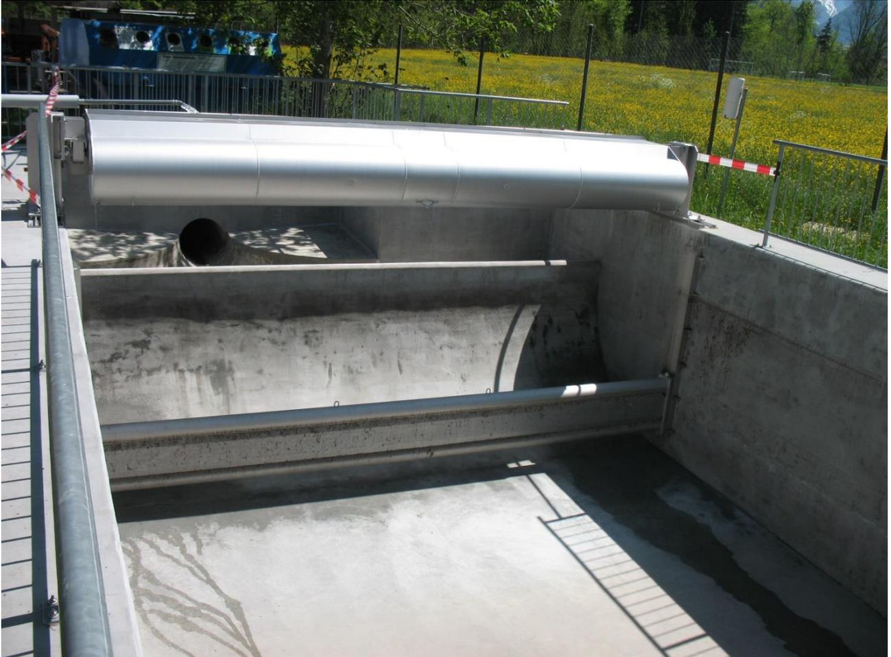
Figure 2: Bac de rinçage dans un bassin ouvert
