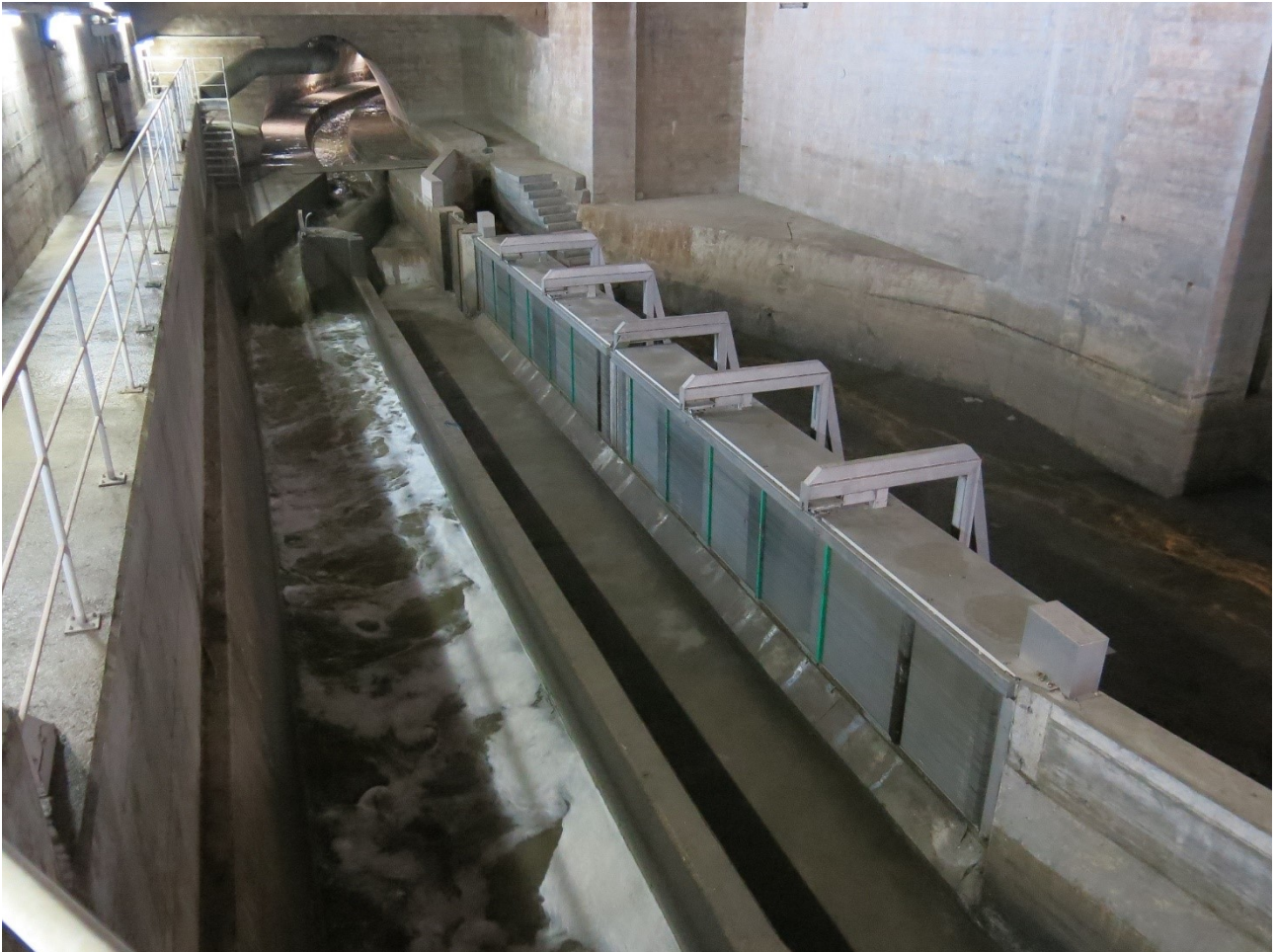
Figure 5: Dégrilleur vertical à disposition particulière à Lausanne, Capelard
