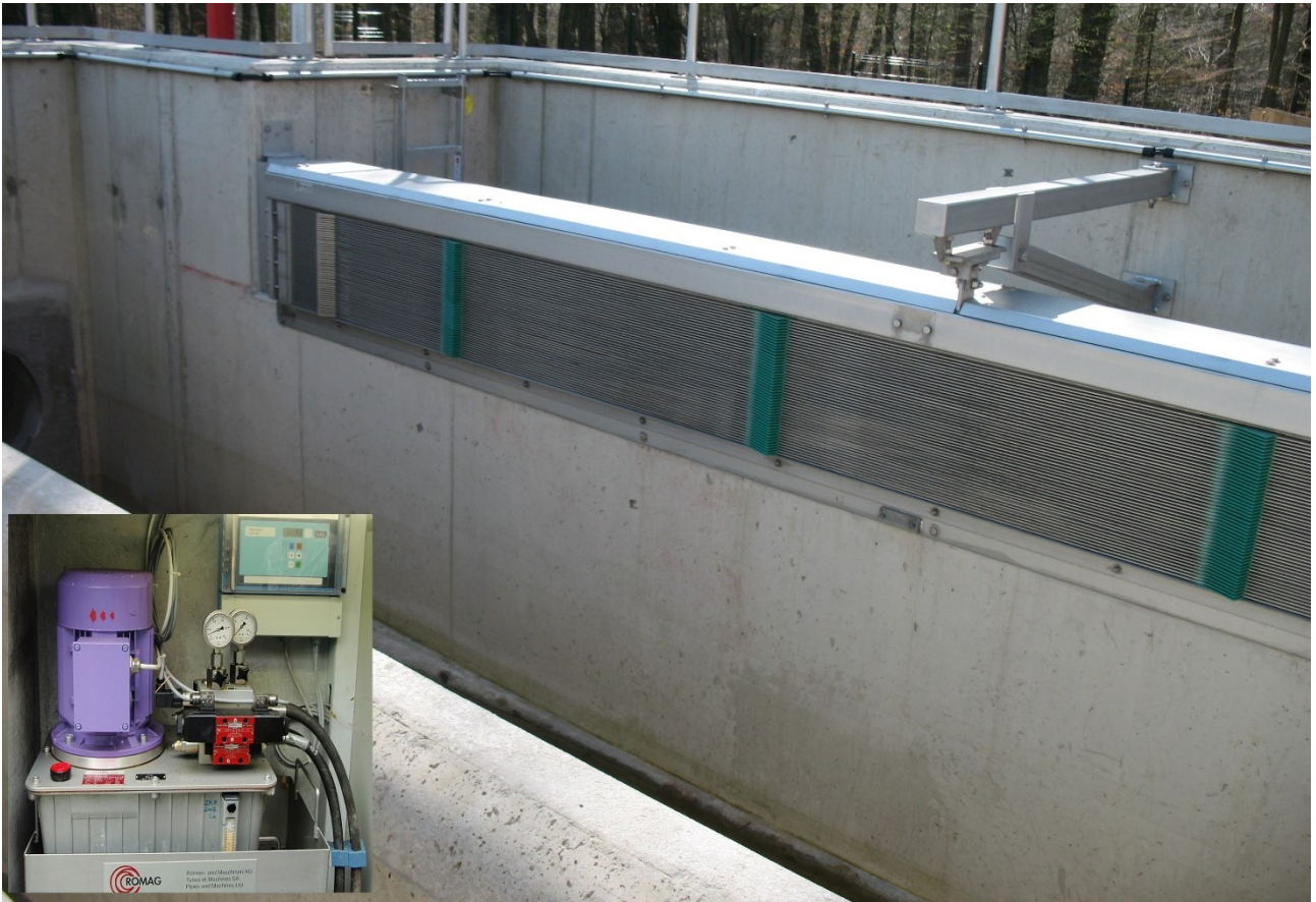
Figure 6: Dégrilleur vertical
