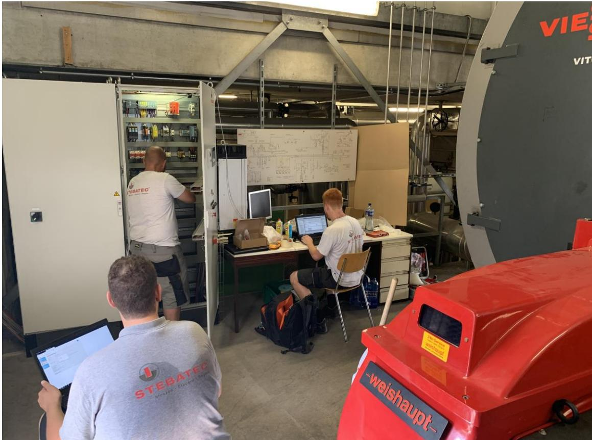
*Bild 2; Mitarbeiter des Dampf- und Heisswasser-Team's der STEBATEC beim Umbau der Kesselsteuerung Schlachtbetriebe St. Gallen AG*
