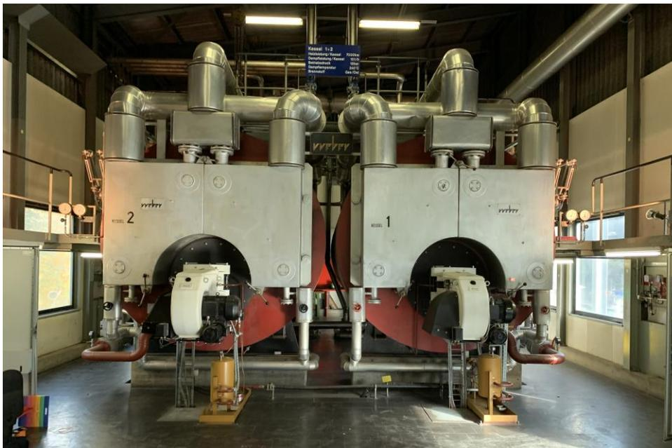
*Bild 1; Dampfkessel als Bestandteil der Zug-Reinigungsanlage einer schweizerischen Bahnbetreiberin.*
