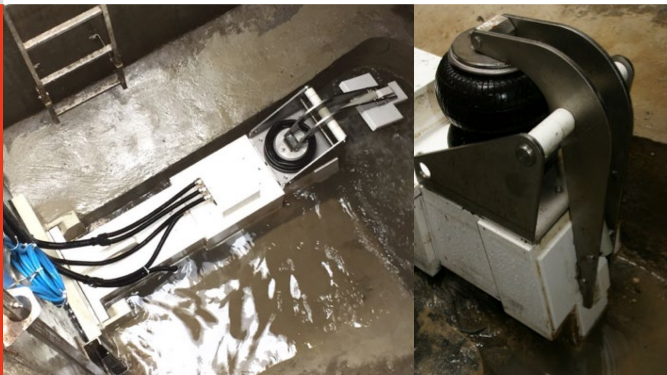
fig. 2 Régulateur d'écoulement pour la limitation dynamique des volumes de débordement.
