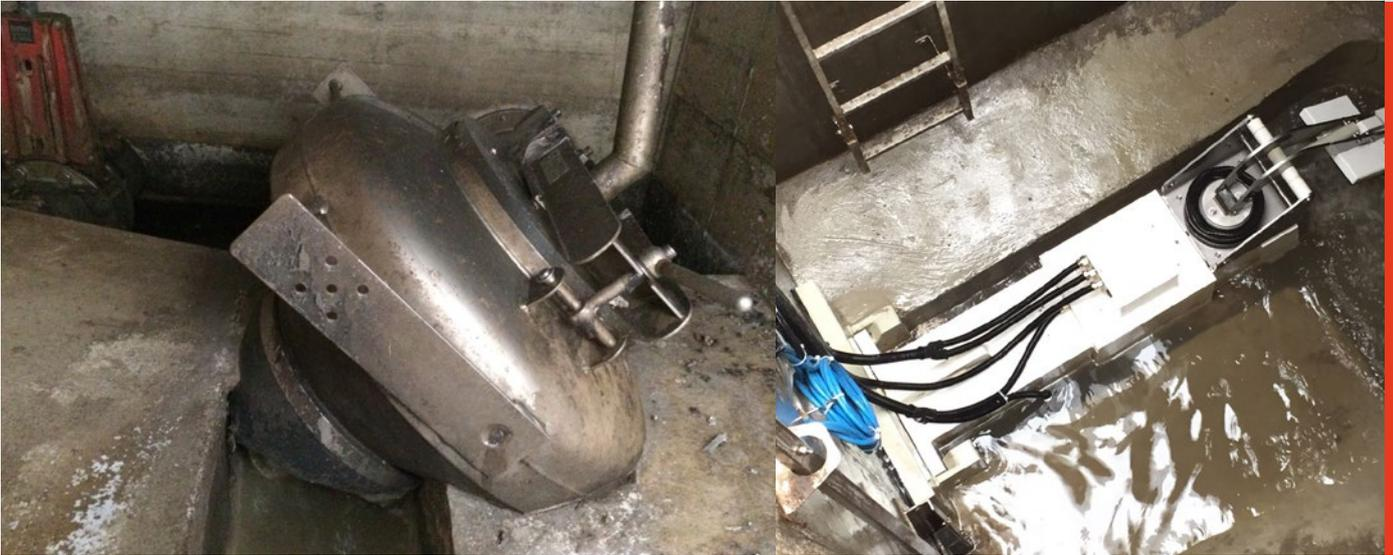
Les anciens régulateurs d'écoulement n'ont pas pu être commandés.
