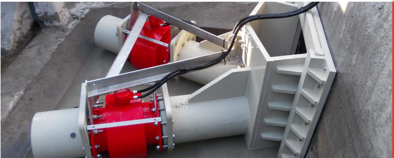
Installation de mesure du flux d'arrivée avant mise en service
