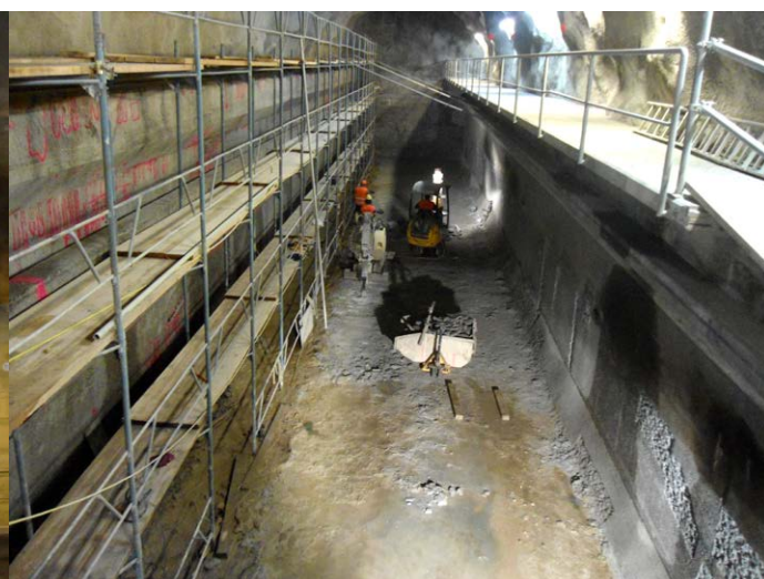
Les travaux d'excavation ont été effectués avec des excavateurs électriques (© Ryser ingénieurs SA).
