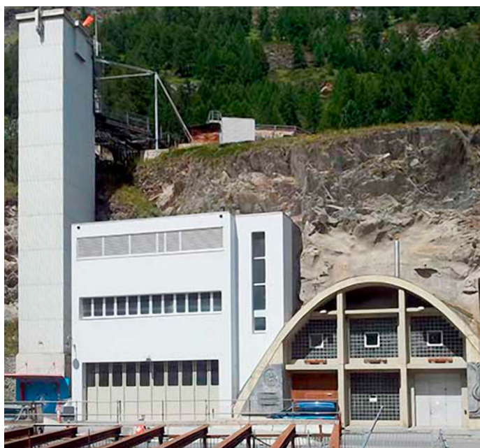
Ne sont visibles de l'extérieur, que le nouveau bâtiment avec le traitement des boues et le portail d'entrée ; tout le reste de la STEP se trouve à l'intérieur de la montagne (© STEP de Zermatt).
