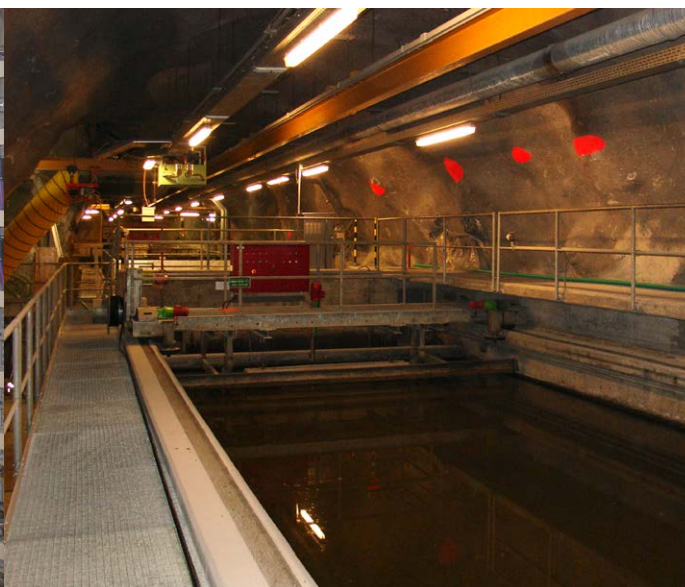
Le pont avec le racleur décanteur primaire a été révisé. A ce moment, nous avons installé un nouveau équipement électrique.
