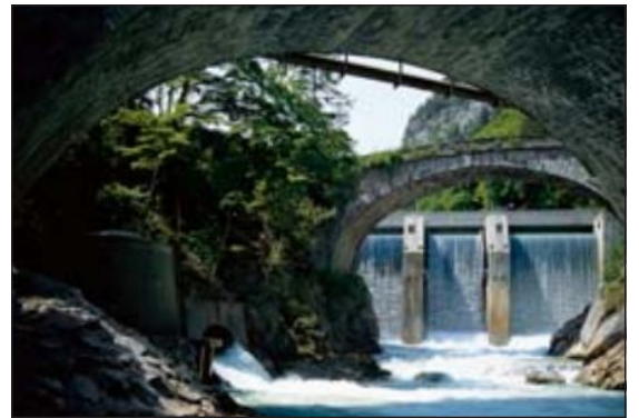
Déversoir de la Simme à Wimmis
