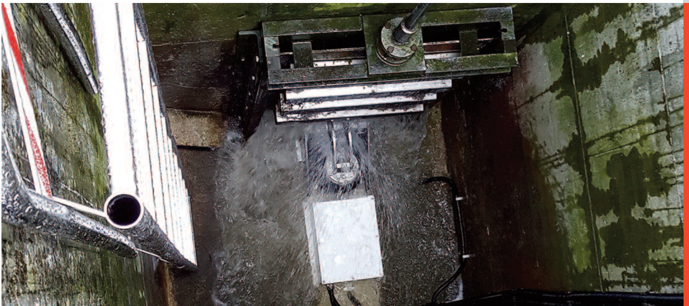
La régulation pneumatique du débit à remplissage partiel mesure et limite le débit de manière dynamique.
