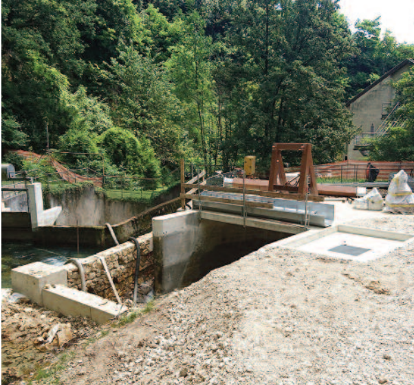
Situation avant l'installation de la nouvelle grille. Les tuyaux visibles sur la photo servent au bief.
