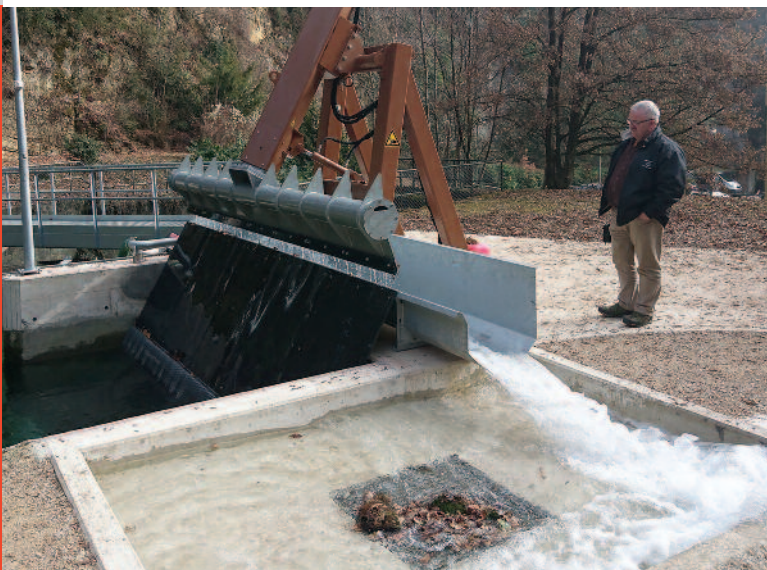
Les objets flottants transportés par le peigne de nettoyage dans la conduite sont rincés dans la cuve en béton avec tamis de fond.
