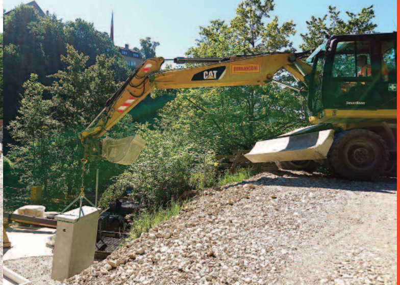
Une des deux cabines en béton est placée par la pelle mécanique.
