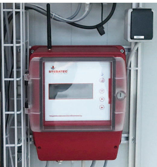
Le convertisseur de mesure de Stebatec fournit les données d'écoulement au système de commande de processus ou optionnellement à des tiers par GPRS.
