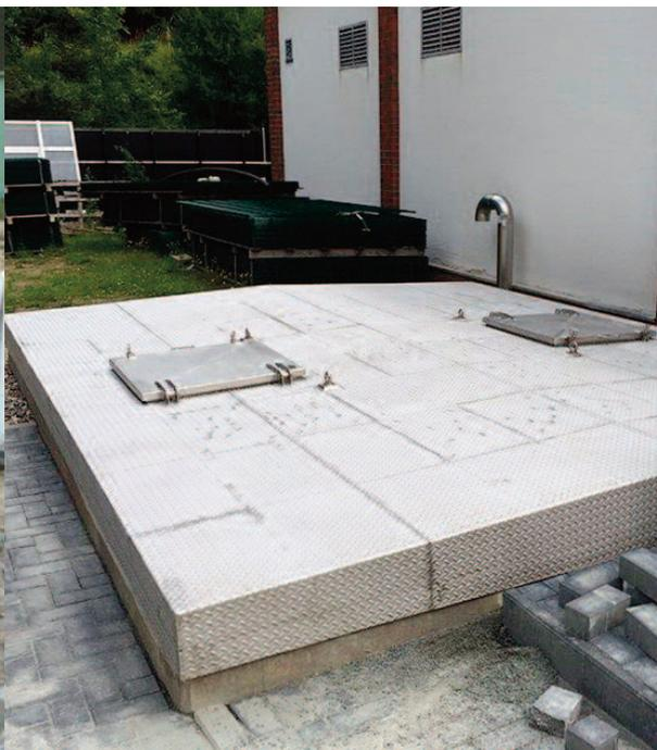
Le puits terminé avec son recouvrement et les trappes d'accès pour les travaux d'entretien et les contrôles.
