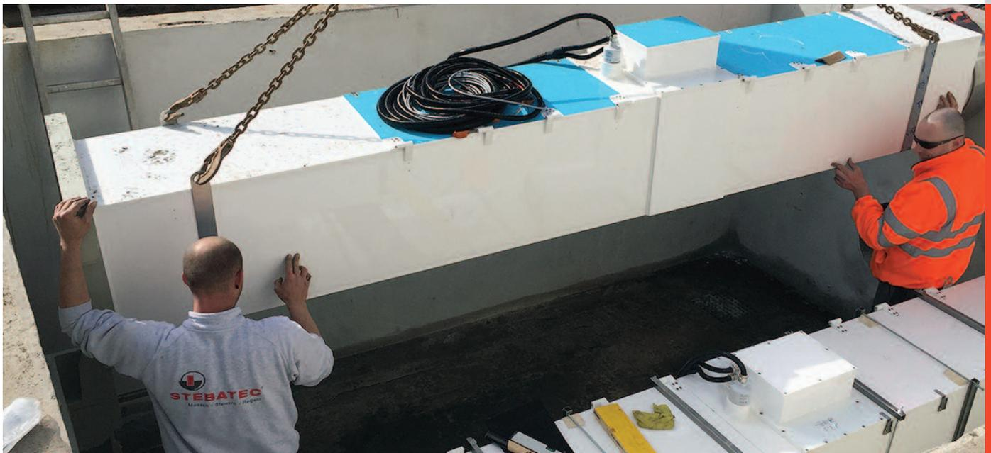
Pour la mesure dans le canal d'amenée, un des deux canaux de mesure calibrés est monté dans le puits. Le deuxième (en bas à droite) est déjà en place.
