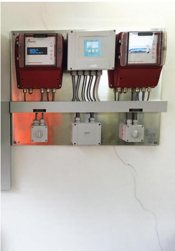
Les convertisseurs transmettent les données au système de commande de processus et optionnellement via GPRS à une entreprise externe de maintenance.
