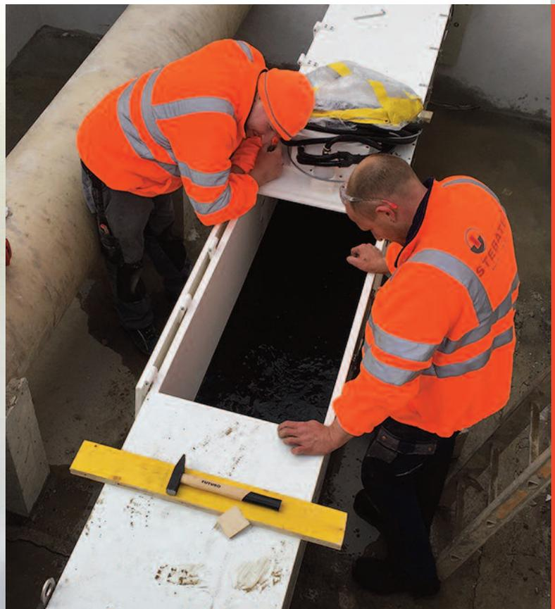
Des trappes de service largement dimensionnées et disposées de manière confortable offrent un accès pratiquement sans restriction pour les travaux d'inspection et de maintenance.
