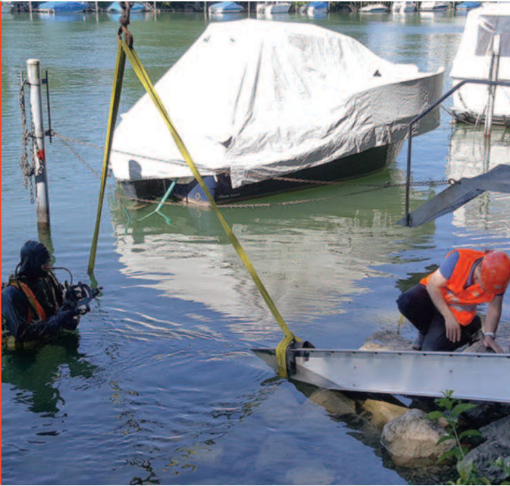
Rail installé. Un plongeur a assuré la fixation sous l'eau
