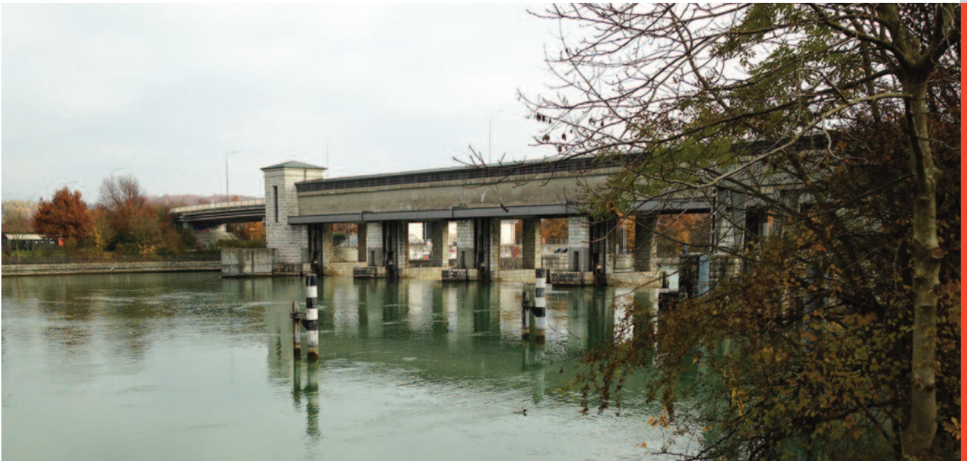
L'ouvrage de régulation à Port régule le niveau des lacs de Neuchâtel, de Morat et de Bienne et commande le débit de l'Aare.
