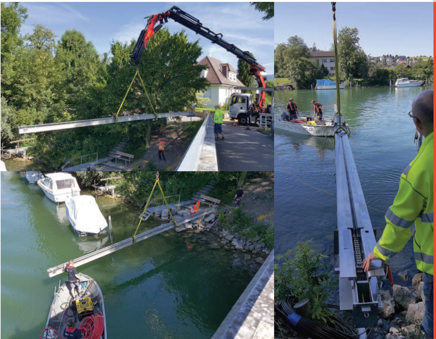
Montage d'un des rails. Une grue mobile le descend dans le canal près des installateurs sur la rive et près du bateau d'un spécialiste en métiers de plongée.
