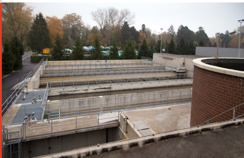
La STEP du Landeron traite les eaux usées de quatre communes des cantons de Neuchâtel et Berne.
