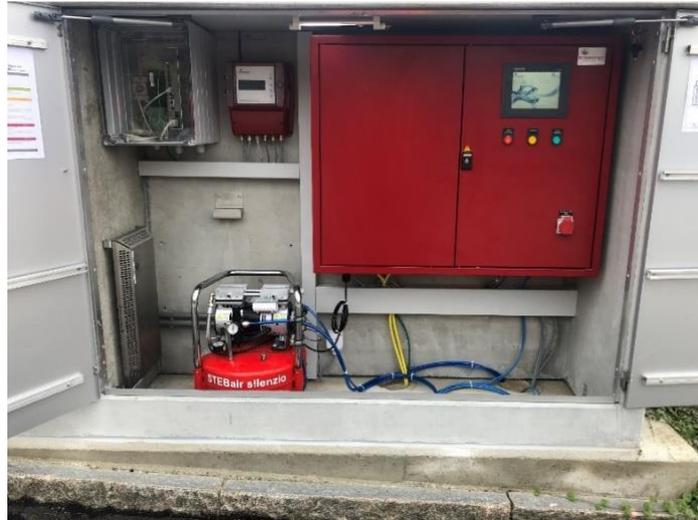
*Figure 3. Cabine avec la commande STEBATEC, compresseur et chauffage. La connexion de données au PCS via un câble à fibre optique est reconnaissable en haut à gauche.*
