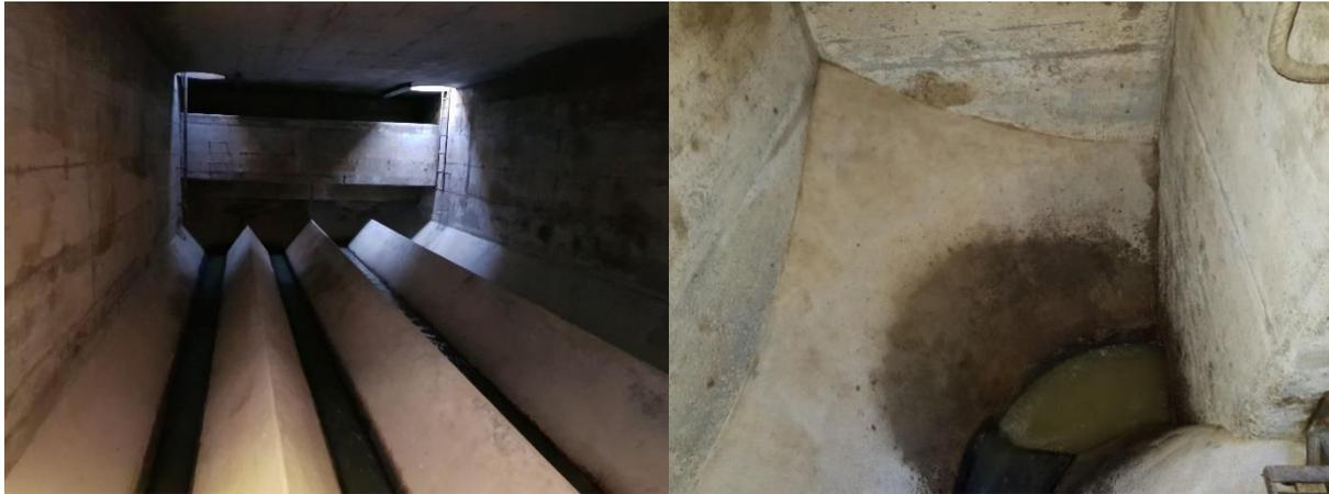
Figure 1. Par temps sec, l'eau coule en zigzag entre les "structures Toberone". Par temps de pluie et lorsque le bassin est rempli, l'eau peut être évacuée dans le canal de déchargement, visible à gauche au fond du bassin. A droite : courbe directement à la sortie du bassin d'eaux de pluie de Dätttau. Après la courbe, la canalisation n'était pas accessible, c'est pourquoi une cloison a été nouvellement construite à l'intérieur du bassin pour intégrer le régulateur de débit pneumatique.
