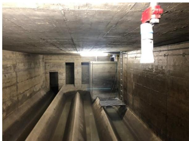
Figure 2. À gauche : un puits a été construit du côté de la sortie d'écoulement du bassin afin de pouvoir utiliser un régulateur de débit pneumatique. En cas de pluie, le débit est ici réduit afin d'utiliser le volume du bassin. A droite : l'accès à la fosse de réduction, qui est spacieuse et sûre après la transformation.
