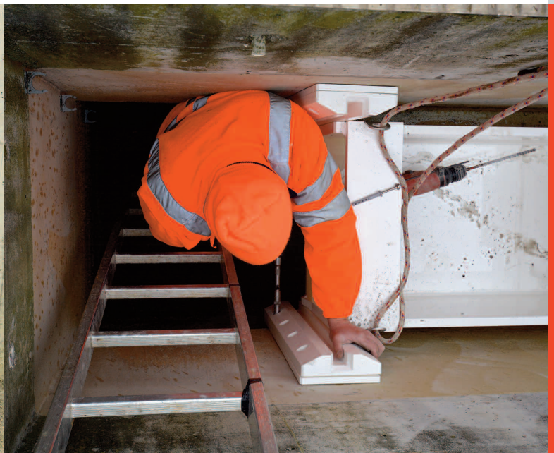
Montage du système de mesure stationnaire partiellement rempli dans la canalisation d'écoulement de la STEP de Radet.
