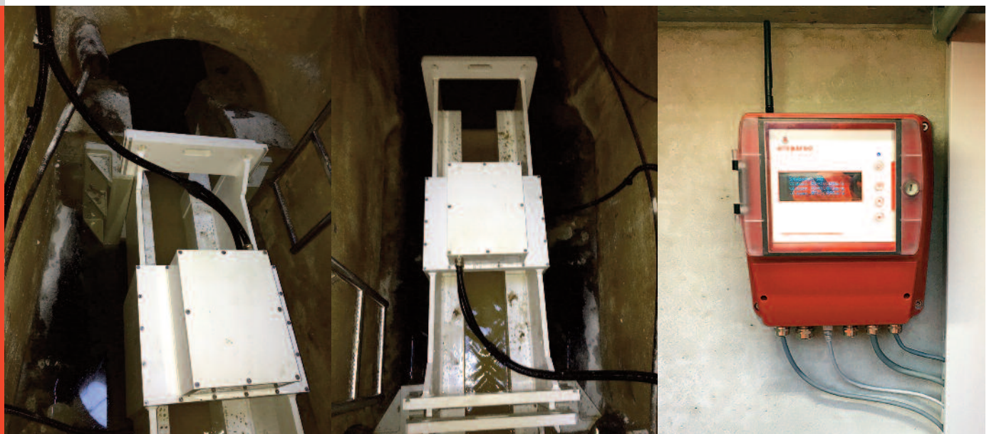
La mesure de débit stationnaire dans des conduites partiellement remplies du point de mesure de Steg à faible débit (ravine uniquement).
