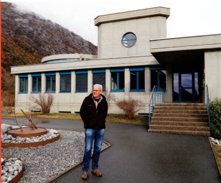
Contremaître de la station d'épuration, Reinhard Bregy, devant le bâtiment d'exploitation de la STEP de Radet.
