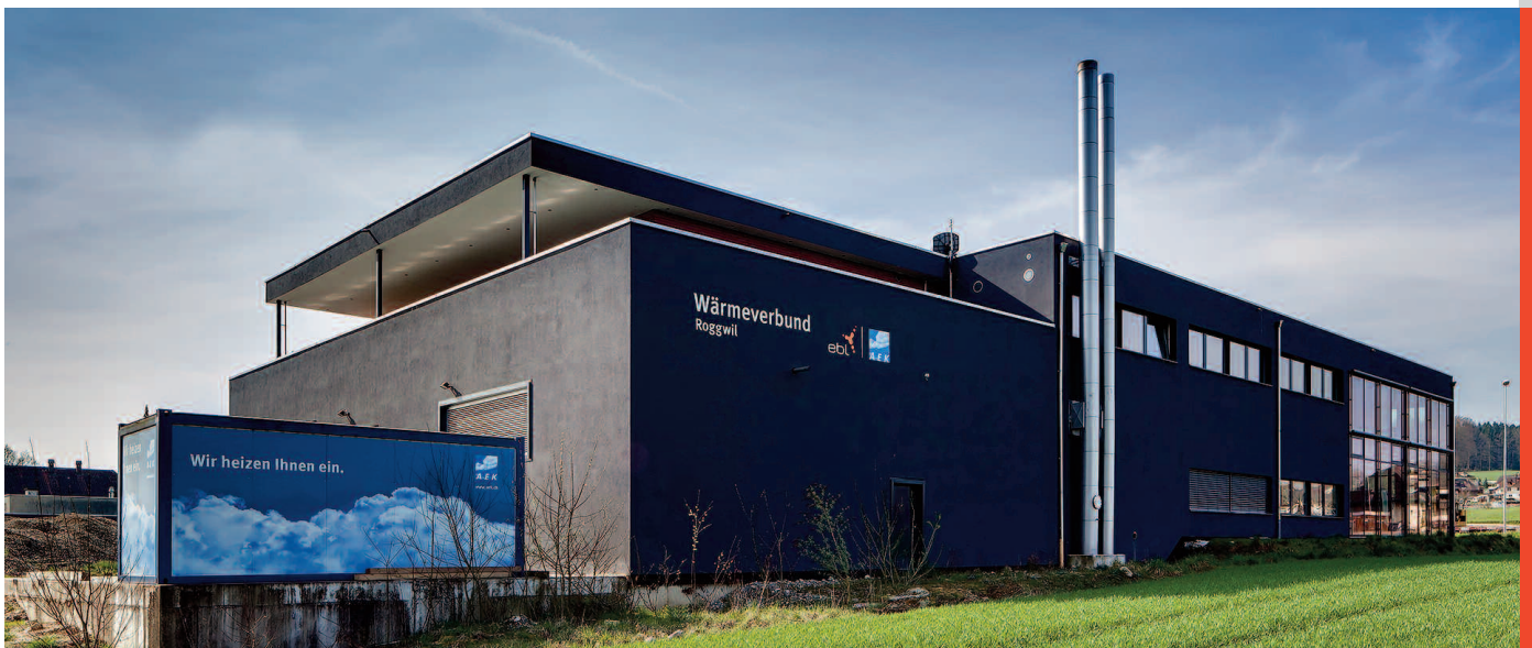
La centrale thermique de Roggwil, l'une des installations d'AEK Energie AG, qui est intégrée dans le système d'alarme STEBalarm.
