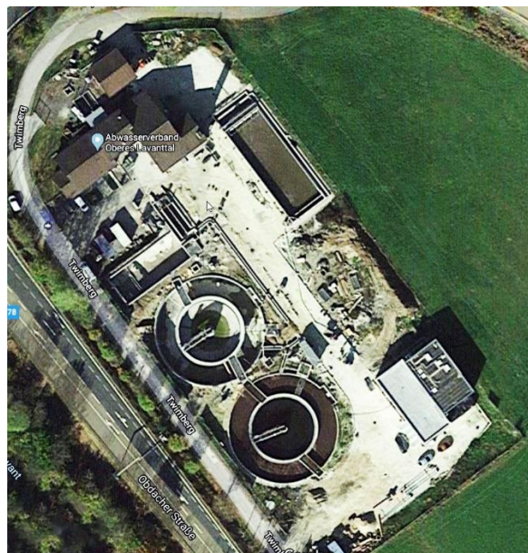
Figure 2 : Vue d'ensemble de la station d'épuration des eaux usées de Twimberg
