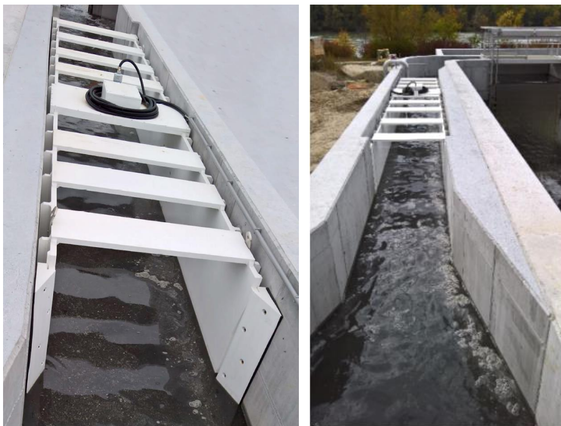
Figure 1: Vue après transformation
