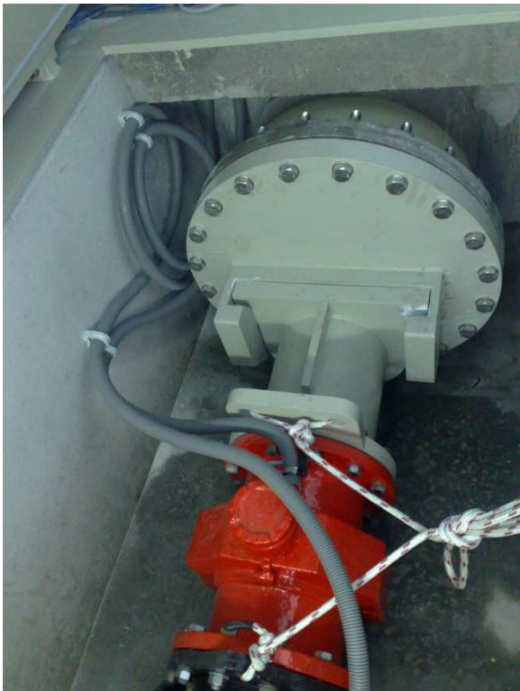
Mesure des eaux usées RUAG (stationnaire NW 250) Point de mesure et couvercle de regard
