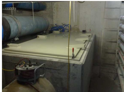
Mesure des eaux usées RUAG (stationnaire NW 250) Point de mesure et couvercle de regard
