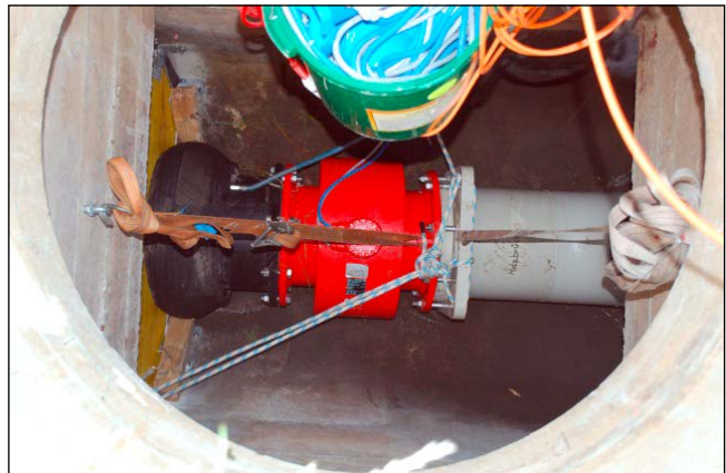
Wangen, Holzbrücke – DN 350
