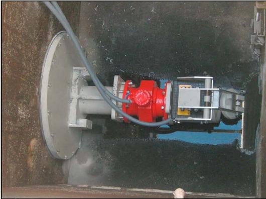
*Pneumatische Abflussregelung in unterschiedlichen Bauformen.*
