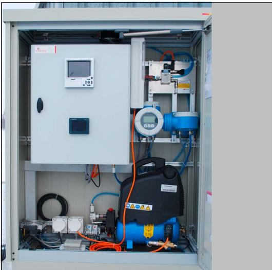
*Freifeld-Aluminiumkabine zur Pneumatischen Abflussregelung vor Auslieferung*
