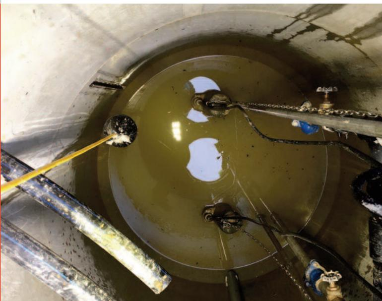
Der Schacht des Hauptpumpwerks, das als einziges mit zwei Pumpen bestückt ist, die alternierend im Einsatz sind.
