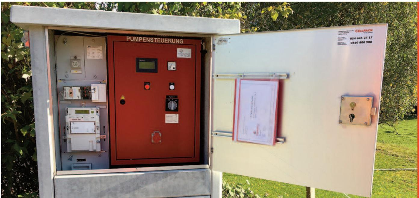
Blick in eine der neuen Kabinen mit der kompakten Pumpensteuerung (rechts) und dem Energiezähler (links).
