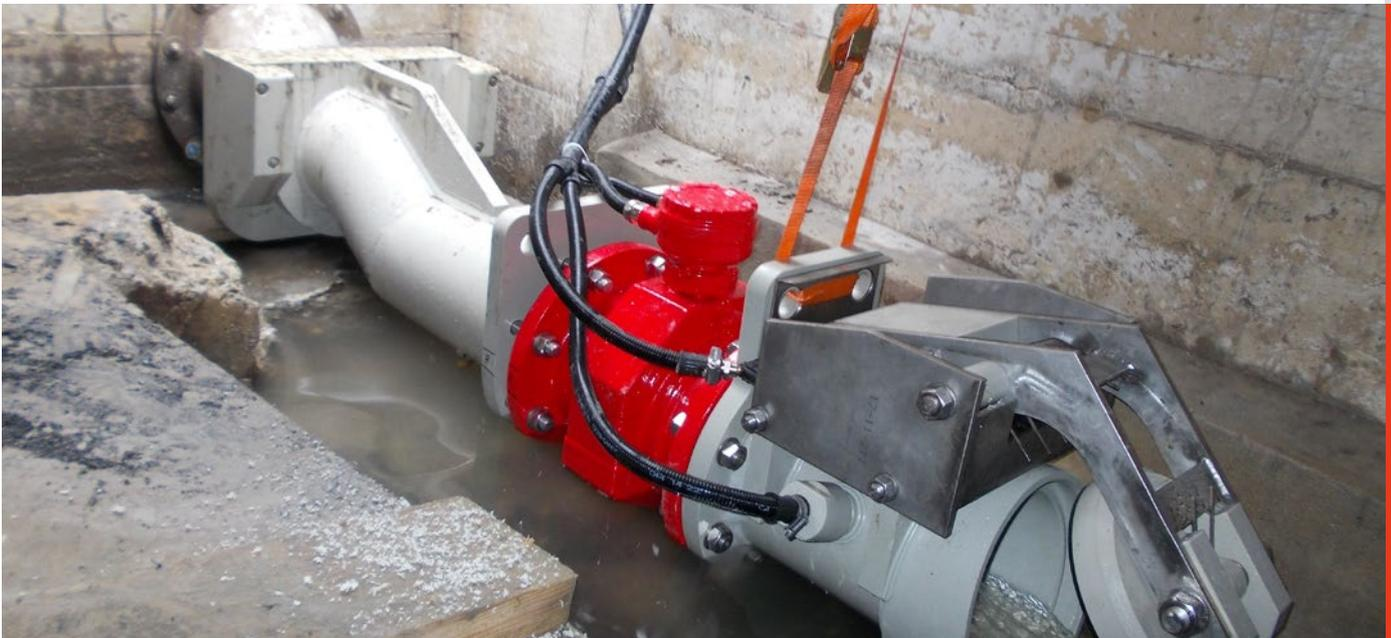
Präzise pneumatische Abflussregler ermöglichen die Optimierung des Kanalnetzes.
