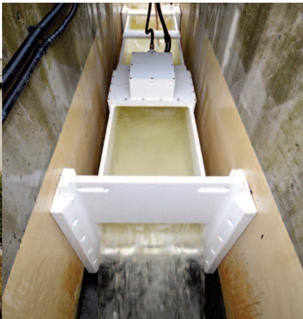
Der Abfluss der ARA Radet wird neu mit einer teilgefüllten stationären Durchflussmessung erhoben.
