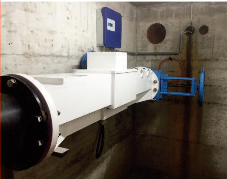
Messstation Oberems mit einer teilgefüllten stationären Durchflussmessung.
