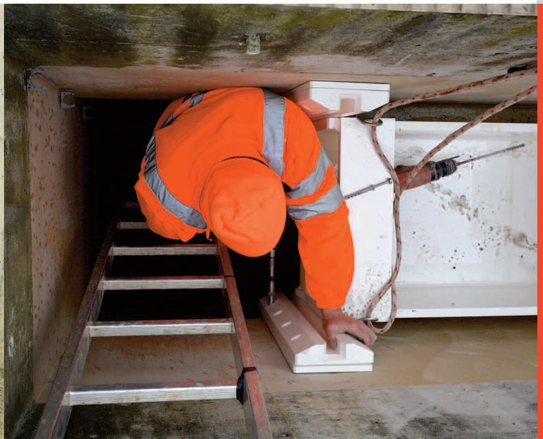
Montage der teilgefüllten stationären Durchflussmessung im Abflusskanal der ARA Radet.
