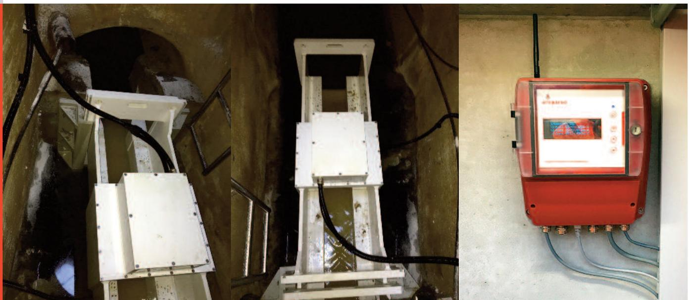
Die teilgefüllte stationäre Durchflussmessung der Messstelle Steg bei geringem Durchfluss (nur Trockenrinne).
