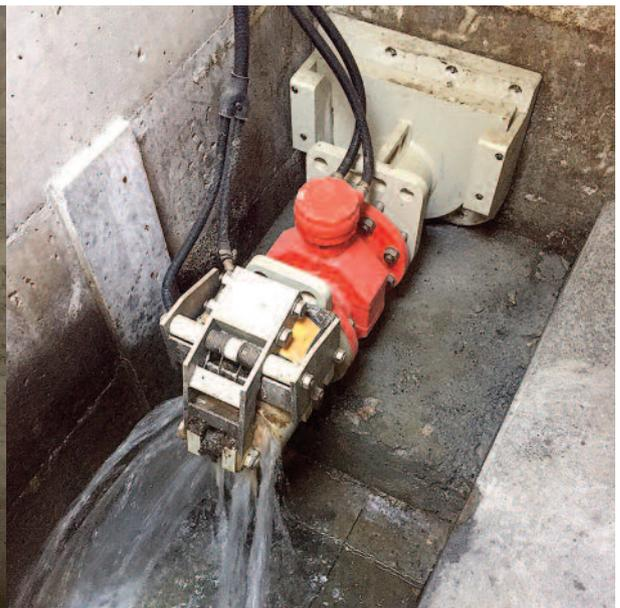
Messstation Eischoll: MID-gesteuerte pneumatische Abflussregelung.
