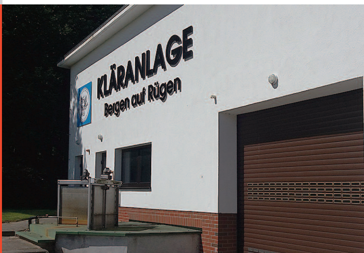
Die Kläranlage Bergen auf Rügen ist eine der Anlagen des Zweckverbands, der die Abwässer der Ostseeinsel bewirtschaftet.
