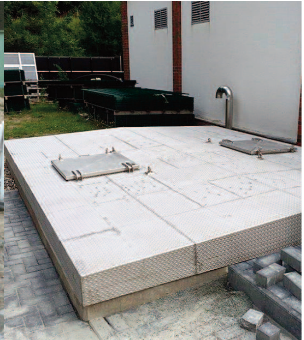
Der fertige Schacht mit der Abdeckung und den Zugangsluken für Unterhaltsarbeiten und Kontrollen.
