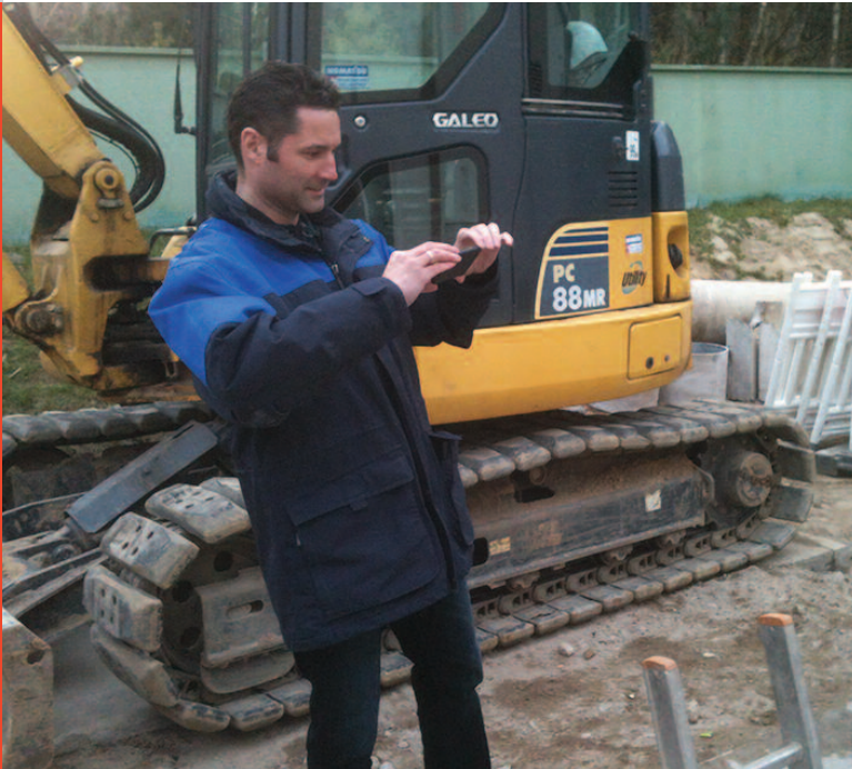
Der Leiter der Kläranlage Bergen, Oliver Heidrich, dokumentiert die Arbeiten am Schacht, der für die Messstrecken erstellt wird.
