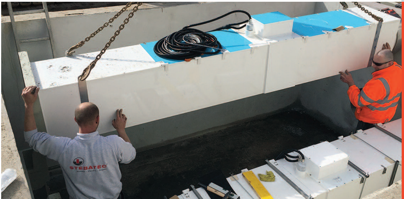
Einer der beiden kalibrierten Messkanäle wird für die Zulaufmessung im dafür errichteten Schacht montiert. Der zweite (unten rechts) ist bereits platziert.
