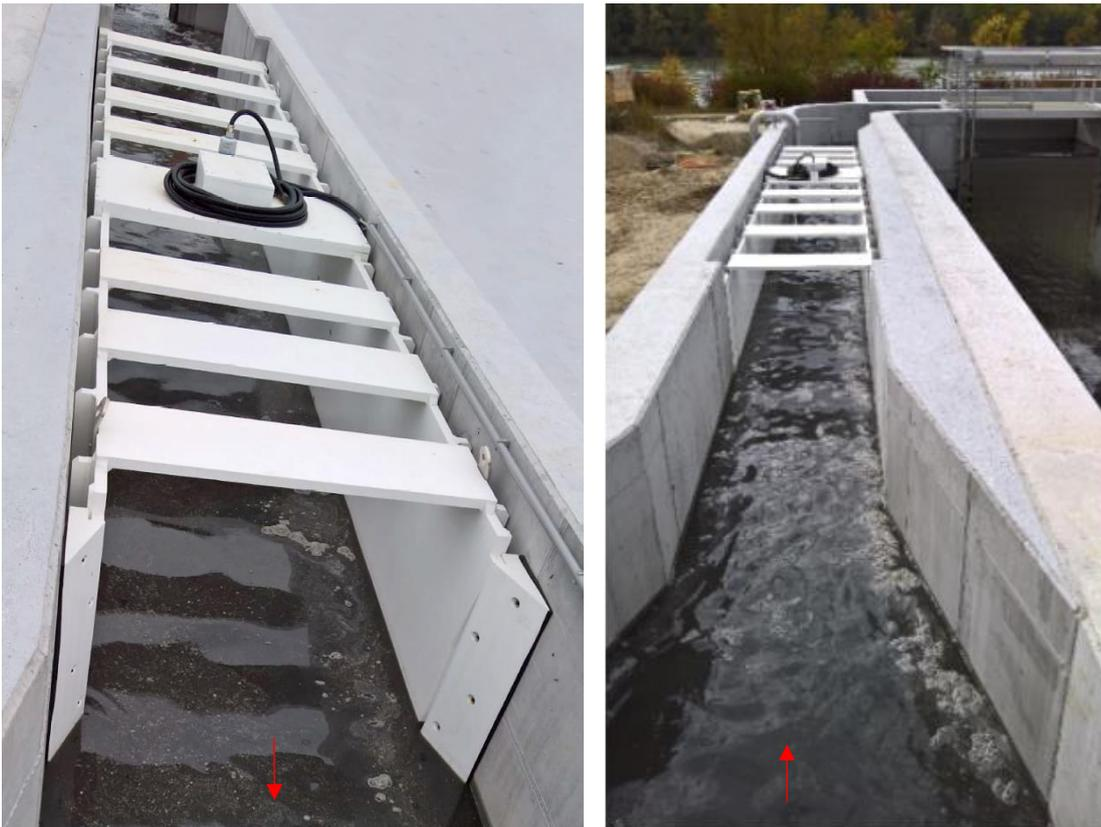
Abbildung 1: Ansicht der neuen Stationär Durchflussmessung teilgefüllt NW 1000 im Kläranlagenzulauf.
