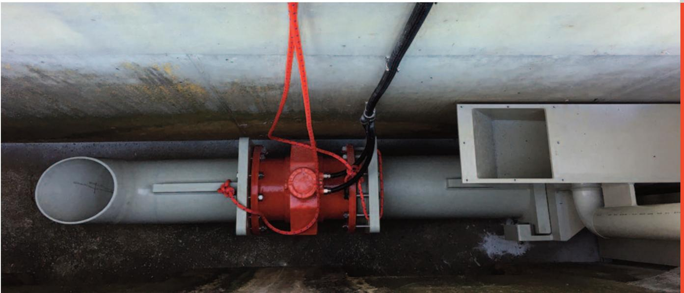
Montage des MID-Geräts der stationären Durchflussmessung sowie des Stauohrs in einem der beiden Schächte.
