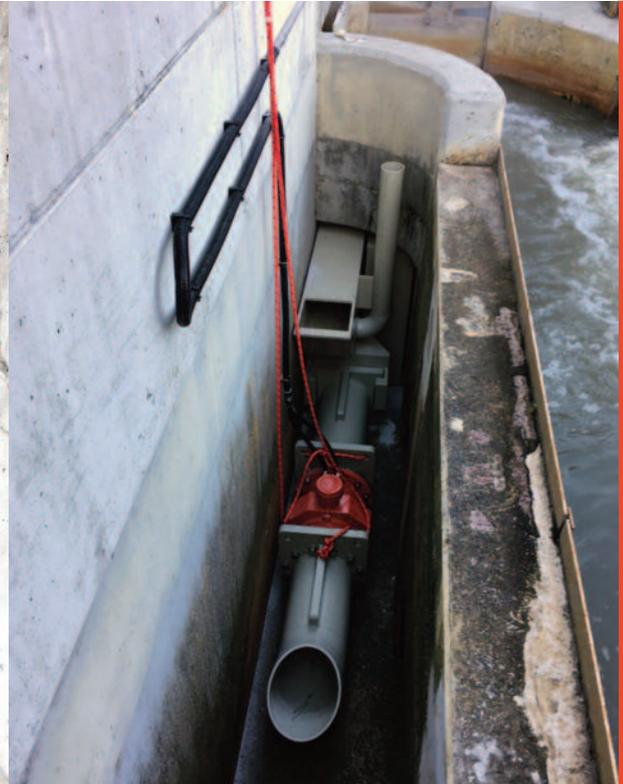
Der linke Kanal während der Montage des MID-Messgeräts. Die eigentliche Entlastung erfolgt bei höherem Wasserstand über die Kante, die von der rechten unteren Bildecke schräg nach oben läuft.
