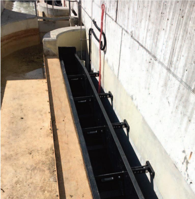
Blick in den rechten, trockenen Auslaufkanal im Anschluss an die Vorklärung.
