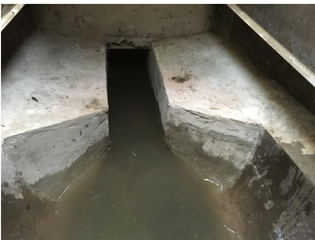
Beispielhafte Kanalausbildung im Zulauf des Abflussreglers, in dem die Kanalform bereits einige Meter vor der Drosselstrecke auf rechteckig transformiert wird.
