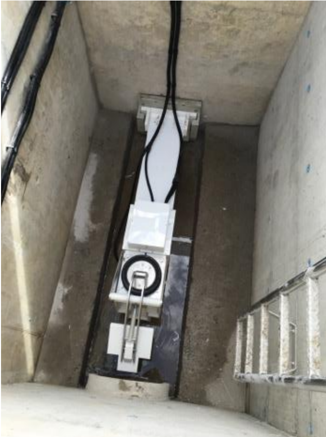
Der nass aufgestellte teilgefüllte pneumatische Abflussregler mit normaler Baulänge.
