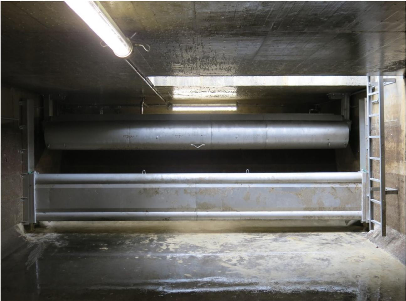
Abbildung 1: Vertikale Tauchwand
