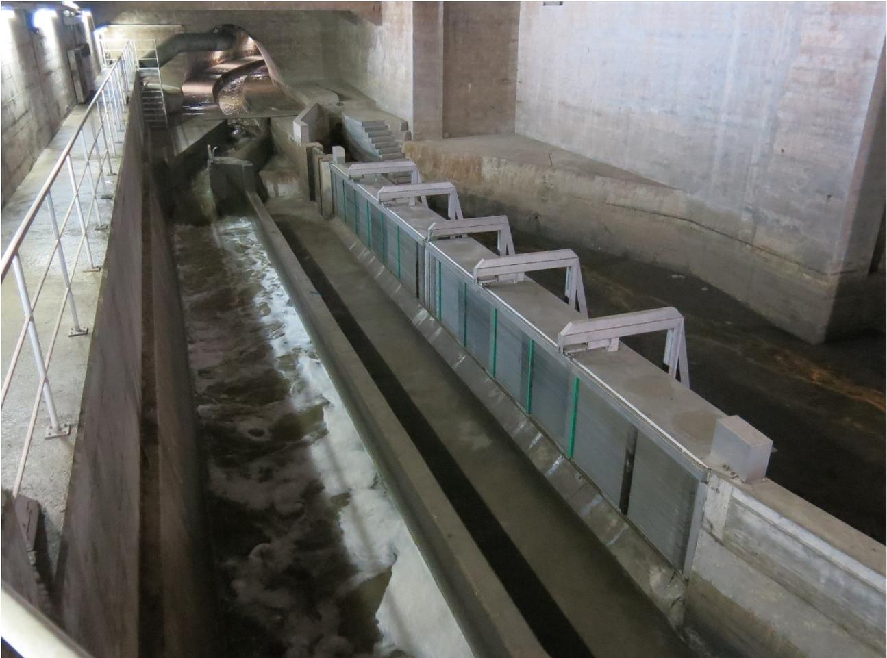
*Abbildung 5: Vertikaler Siebrechen mit besonderer Anordnung in Lausanne, Capelard*
