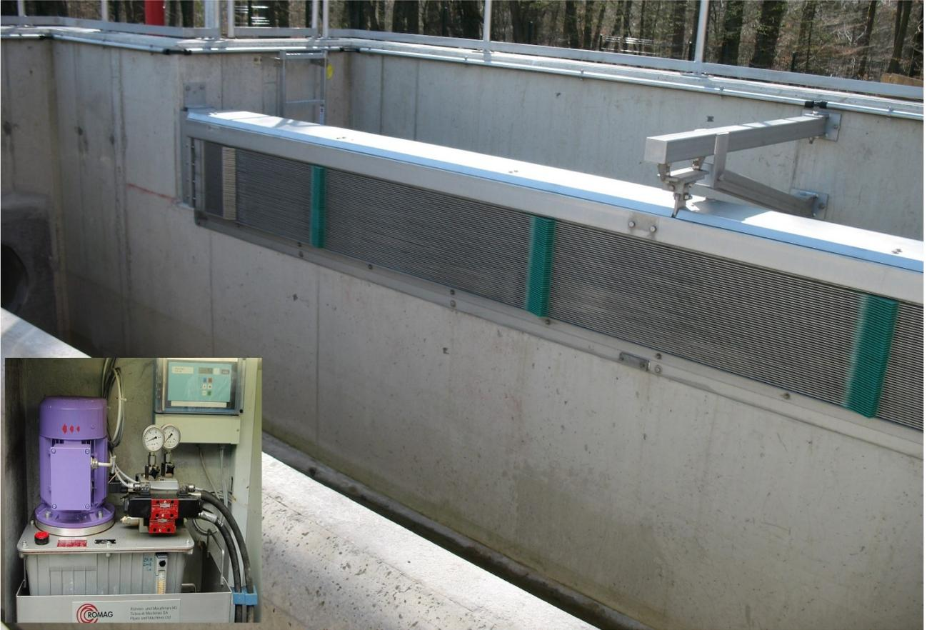
Abbildung 6: Vertikaler Siebrechen
