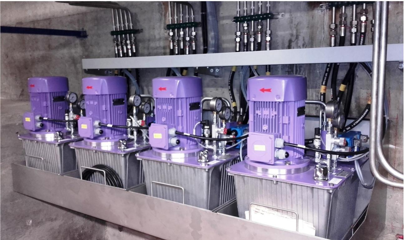
Abbildung 7: Hydraulikanlage für mehrere Siebrechen
