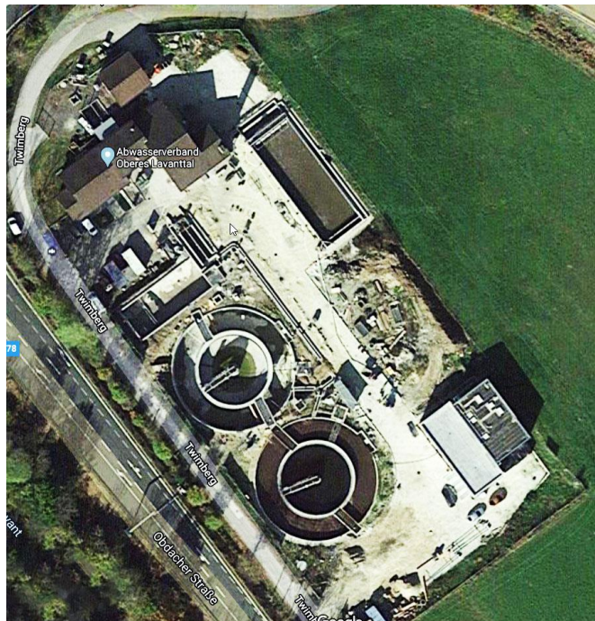
Abbildung 2: Übersicht Kläranlage Twimberg
