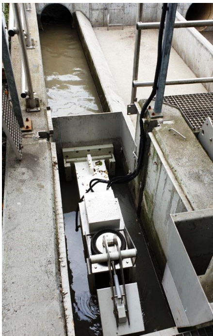
Abbildung 1: Installierte Zulaufregelung
